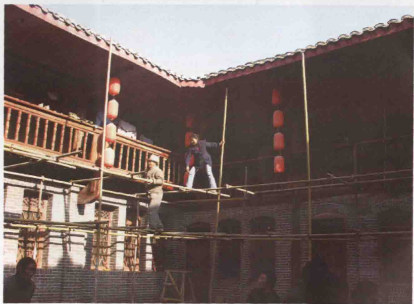
2008.5.12. 地震后古建筑维修现场
