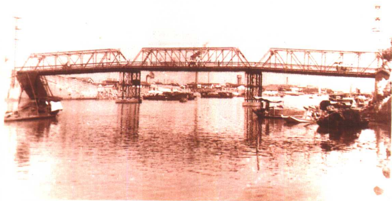
民国时期的吴桥(市政建设总公司供稿)
