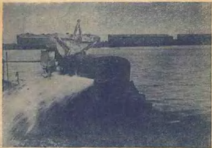
天津市製造的25匹馬力木炭引擎，帶動低壓抽水機
