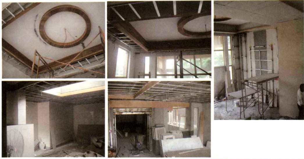
图1.11 住宅空间设计施工现场照片 文健 摄
