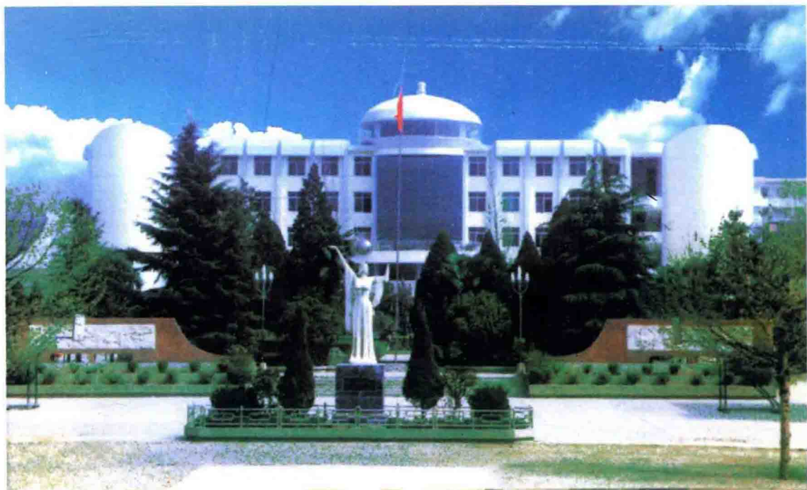
综 合 实 验 办 公 楼
