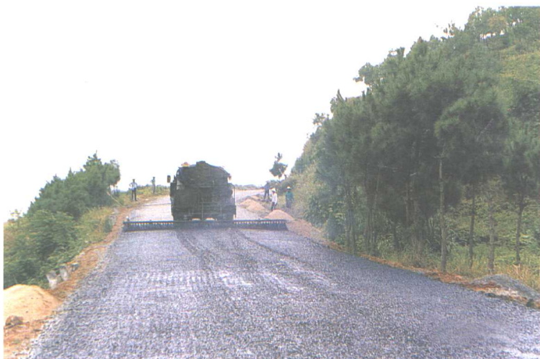
沙吕线铺上柏油路面
