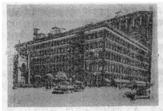
图1 wanamaker百货大楼, 纽约市,建于1859—60年 在当时为最大的利用铸铁作立面构件的建筑实例
