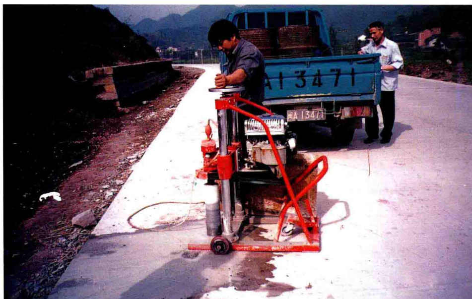
县公路质监站人员对已浇砼路面钻孔取芯进行质量检测
