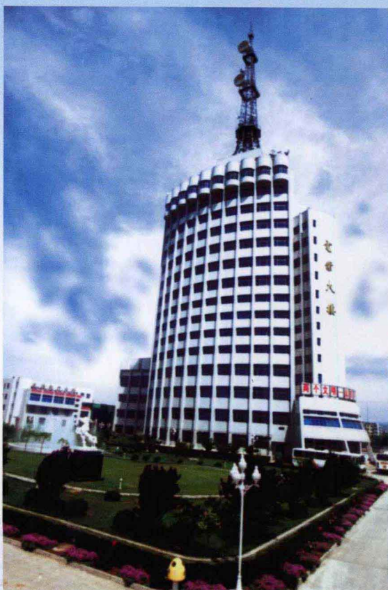
焦作供电公司办公楼
