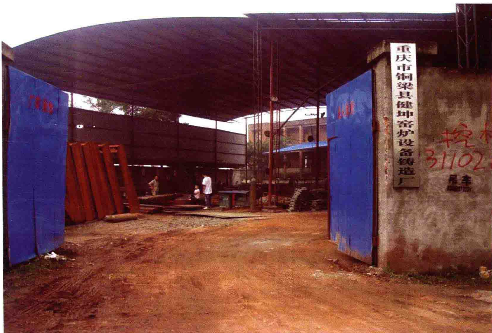
已投入生产的重庆健坤窑炉设备制造厂
