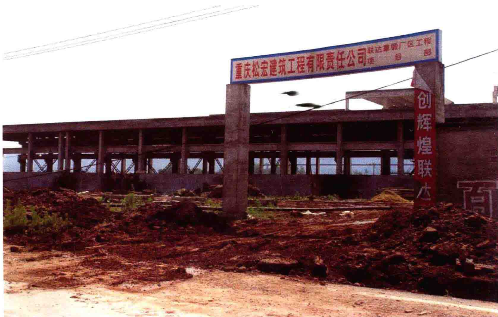
建设中的重庆联达重锻有限公司
