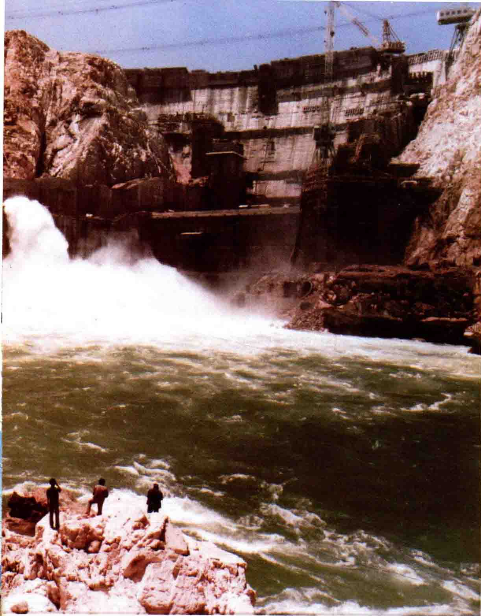
10 龙羊峡水电站拦河大坝。
