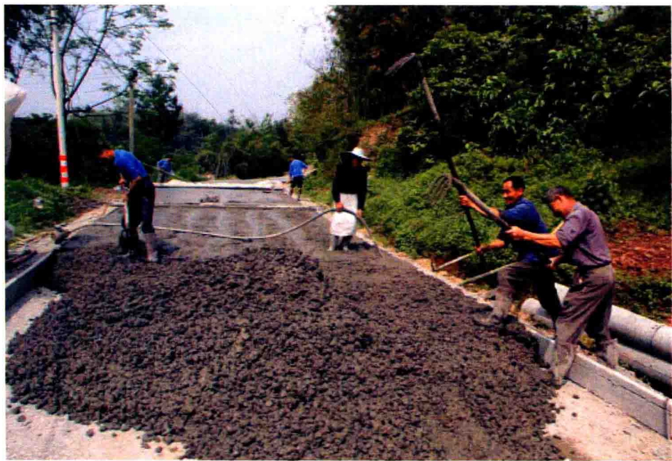
大庙镇新农村公路建设
