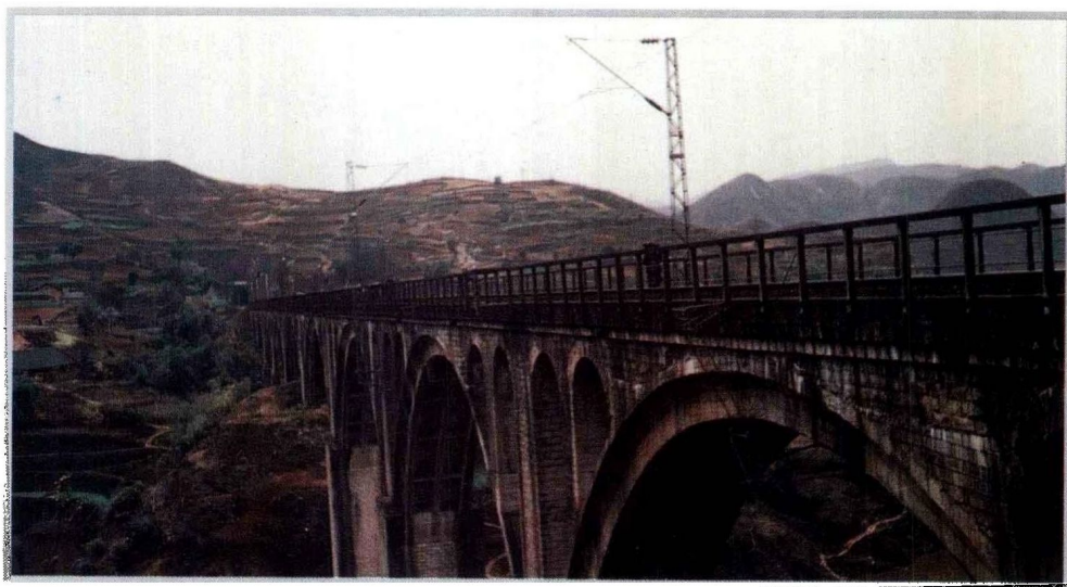
湘黔铁路满溪一号大桥
