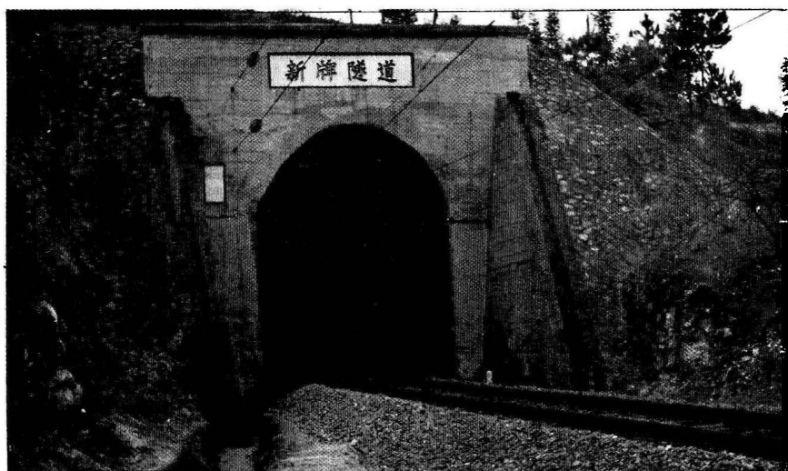
湘黔铁路贵州段最长的隧道——新牌隧道
