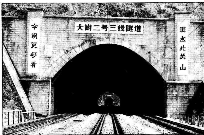
大沟二号三线隧道
