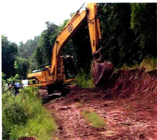
农村重点公路建设，开挖路基情景
