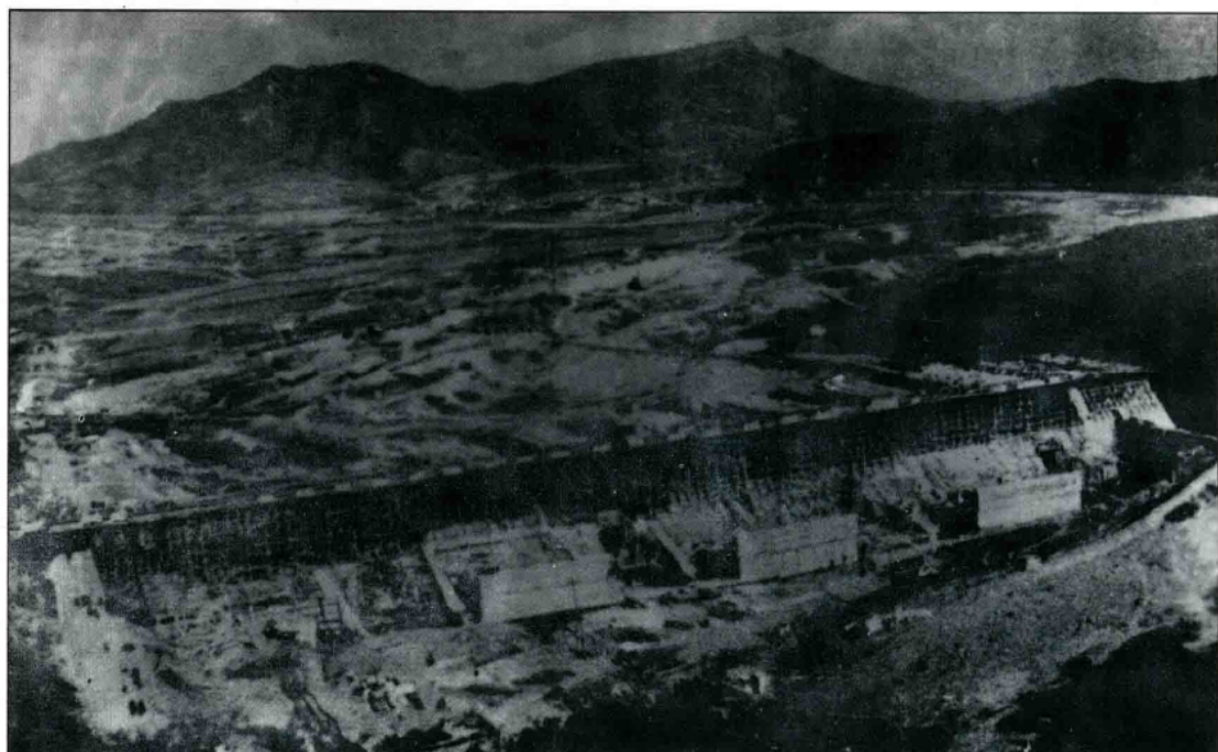
建设中的参窝水库
