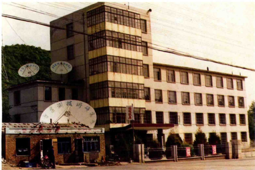
水库调度中心
