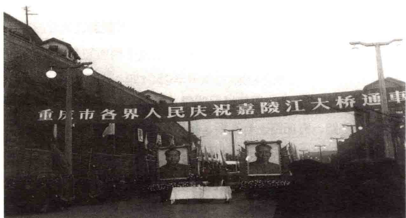
1966年1月20日，重庆首座跨嘉陵江公路大桥建成通车
