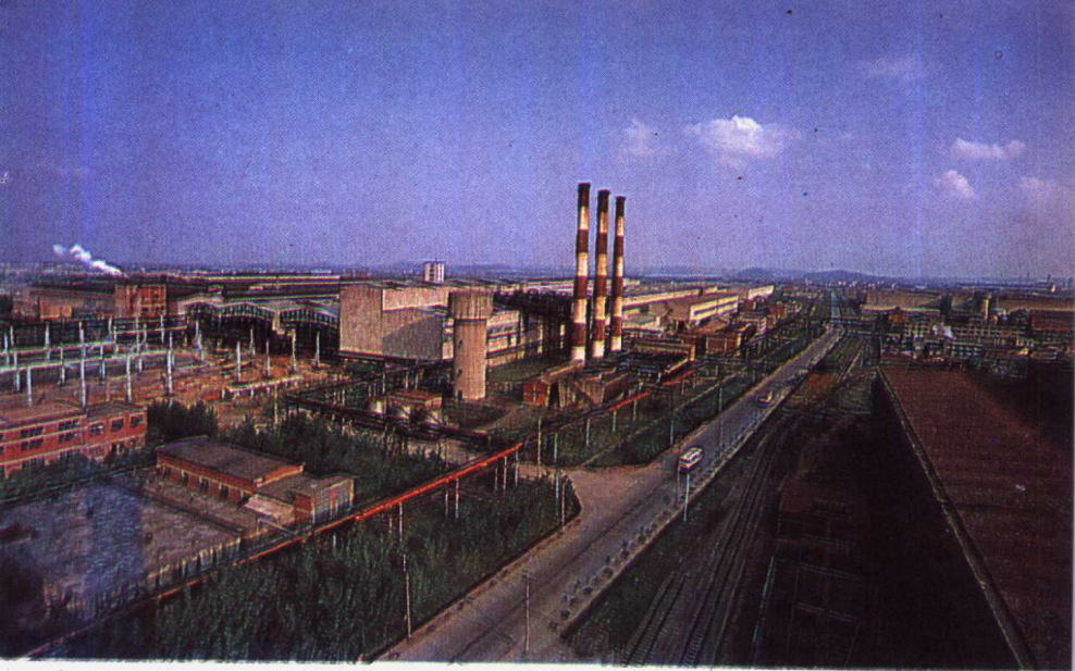
武汉钢铁公司热轧厂、冷轧厂、硅钢厂。
