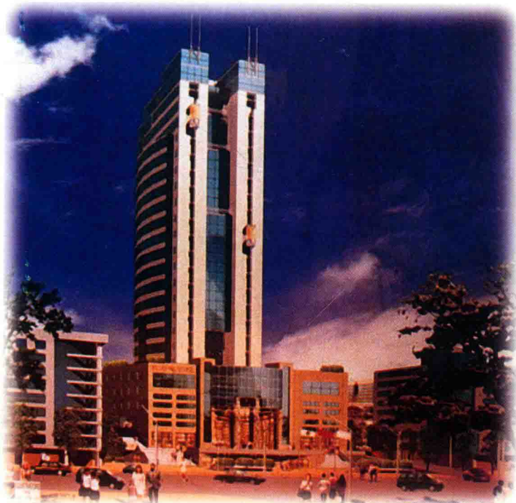
建设中的电影公司文贸大厦
