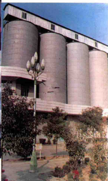
▼ 随州市面粉厂的钢板圆筒仓
