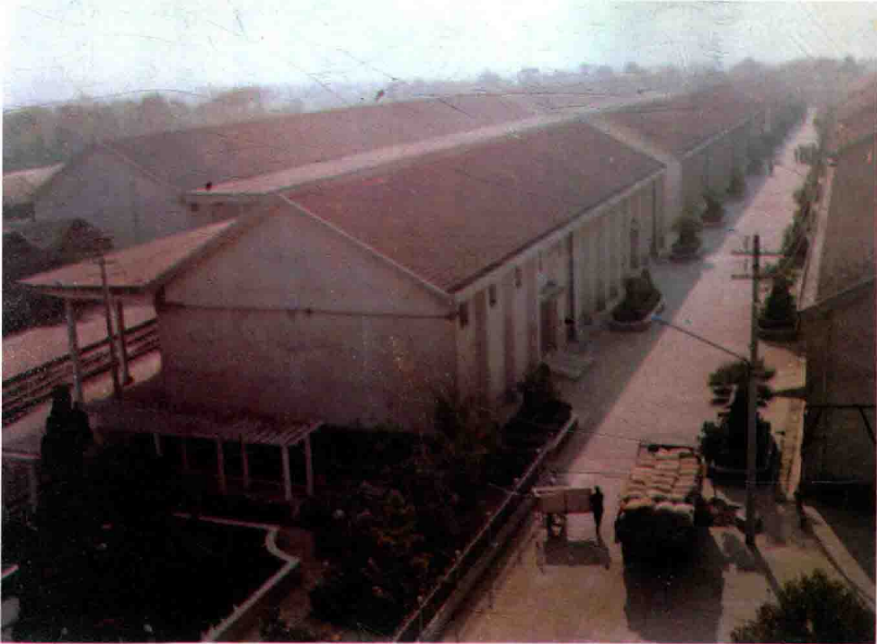
▲襄阳粮食中转储备库（襄樊市襄阳城南门外）库区及铁路专用线
