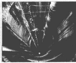
3.混凝土井壁施工:
