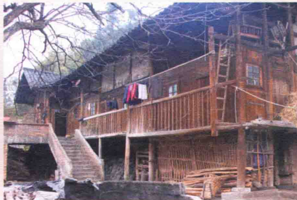
(图十五 干溪苗寨吊脚楼)
