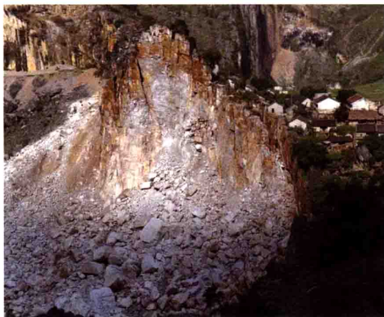
图 20-2 2010 年 7 月 1 日，广西壮族自治区凌云县伶站瑶族乡伶兴村发生山体崩塌（来源：新华网）
