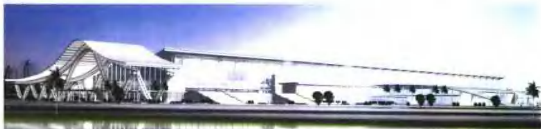
广州国际会展中心(玻璃、铝板幕墙，用白云 SS621，SS611，SS721，SS622 胶)
