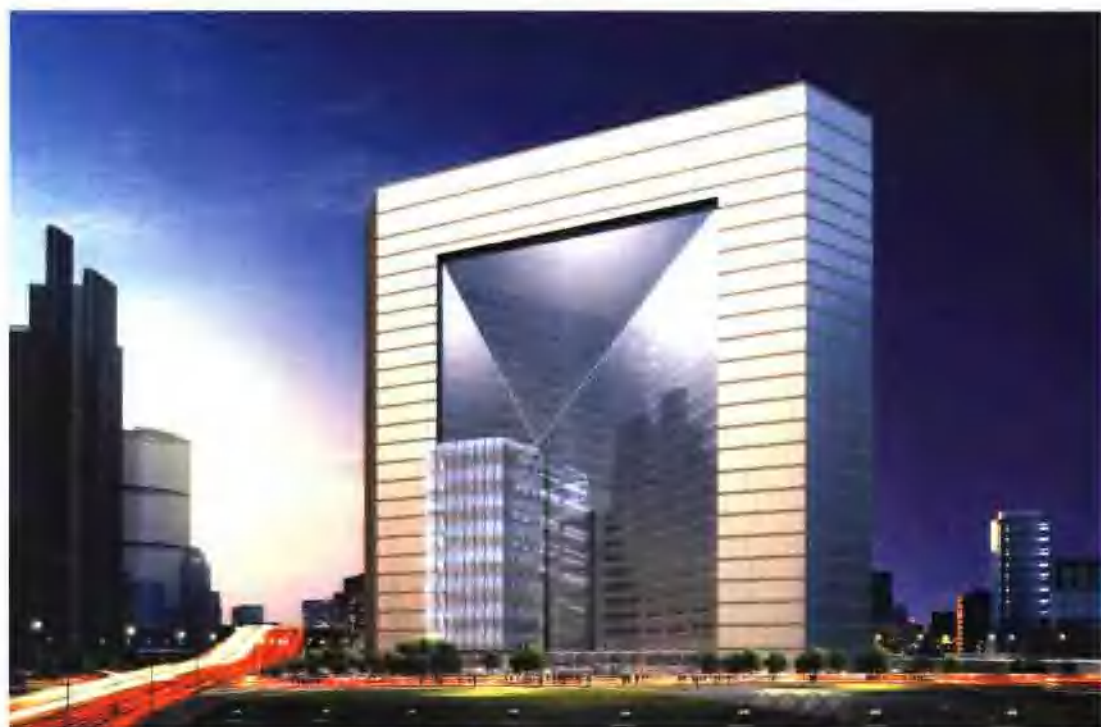
北京新保利大厦正立面 (单层索网玻璃幕墙)
