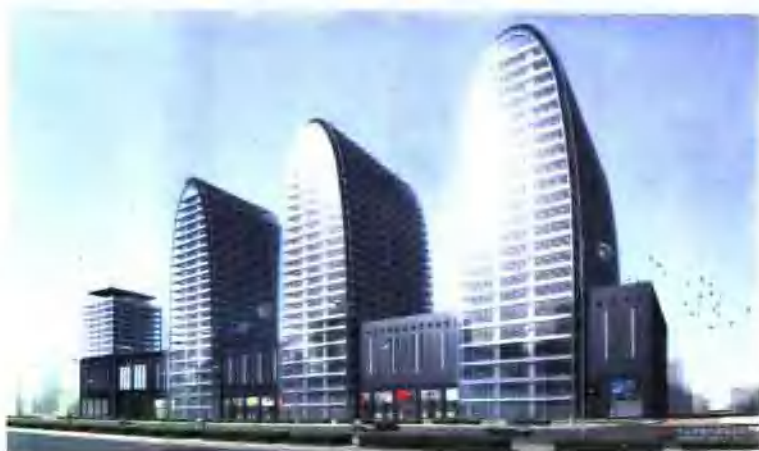
北京西直门综合交通枢纽及配 套服务用房(玻璃幕墙,用白云 SS911、SS922胶)
