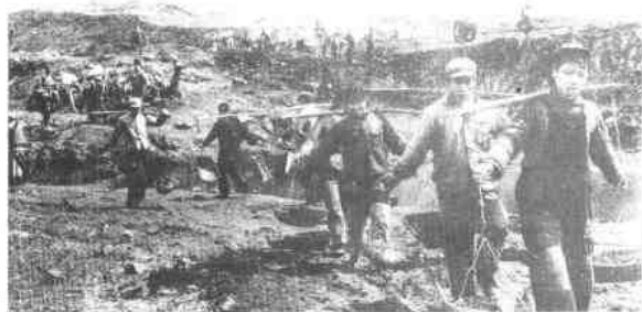
◀ 株洲车辆工厂在建厂初期，全厂职工在基建工地参加义务劳动。
