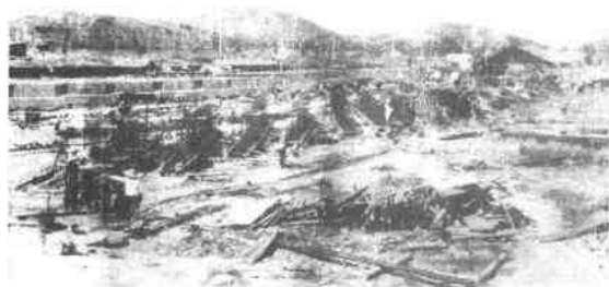
◀ 株洲车辆工厂建厂初期的地况。
