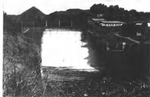
官庄水库溢洪道▶
