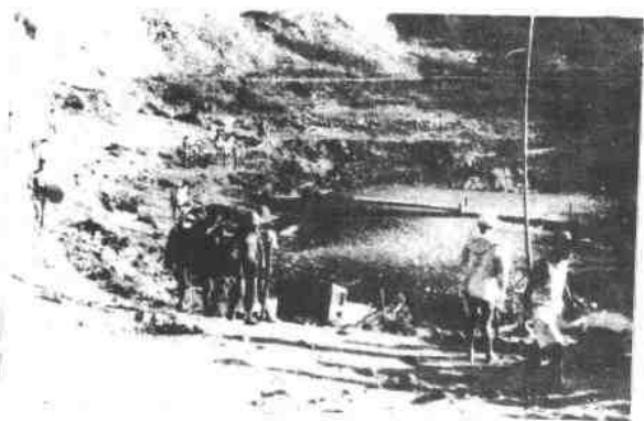
◀ 株洲桥梁工厂建厂施工现场。
