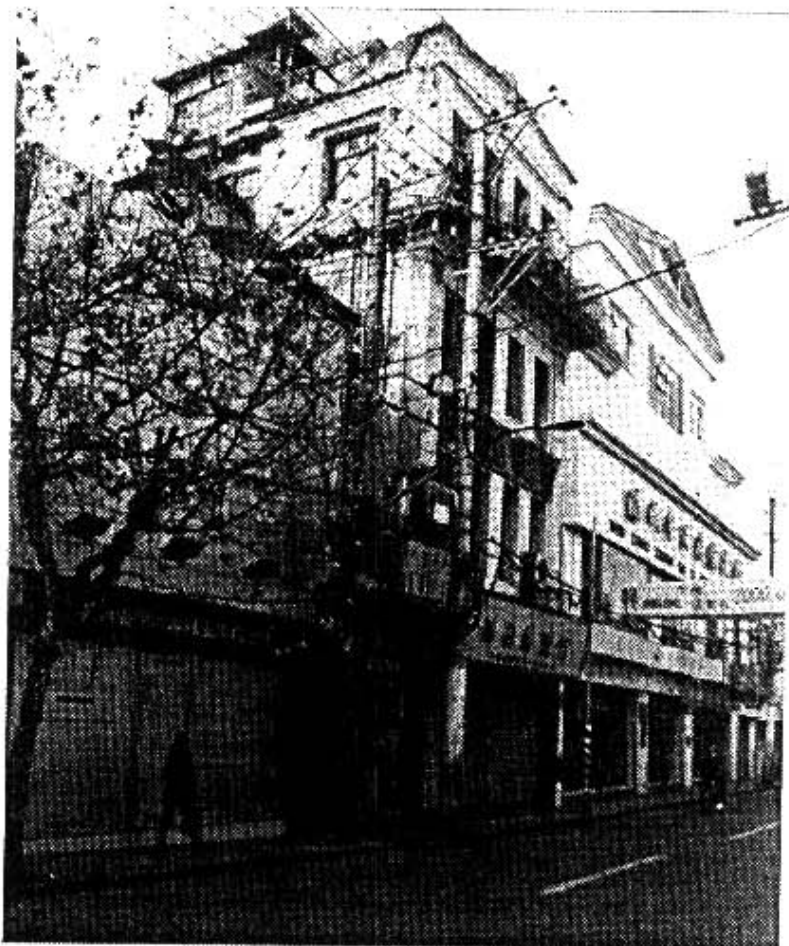
图2-9 沿街高压配电箱
