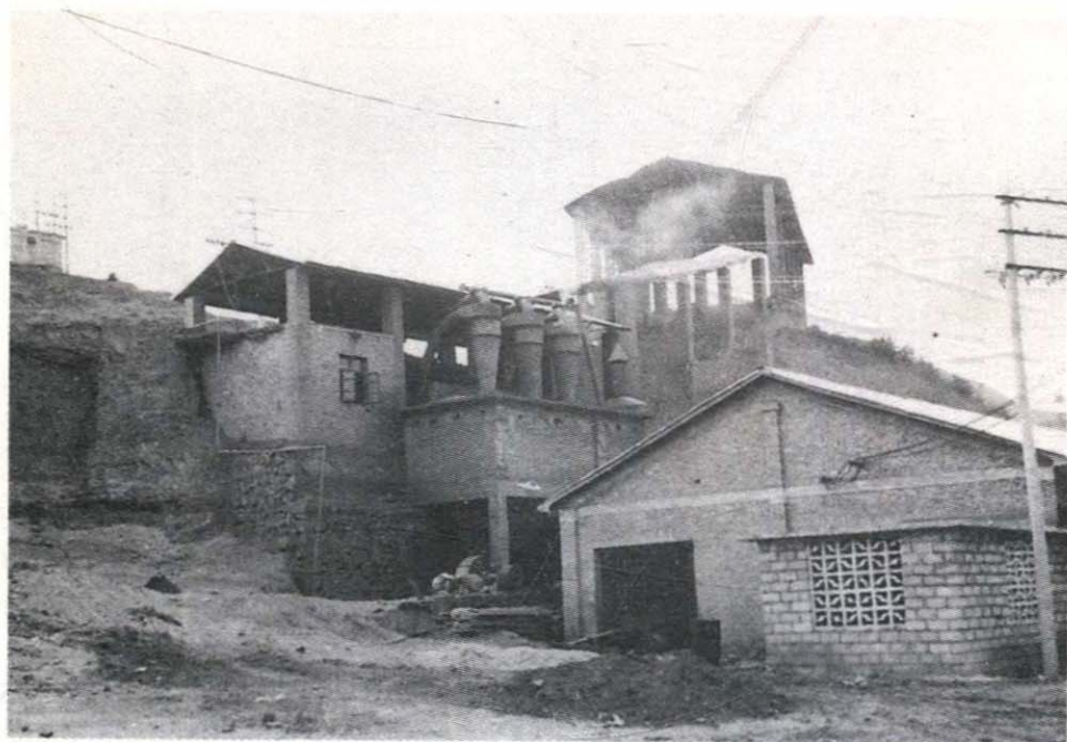
大则勒煤矿是一个村办煤矿，曲靖地区第一批土焦改造试点之一，兴建的矸石砖厂又是我区乡镇煤矿第一家。
