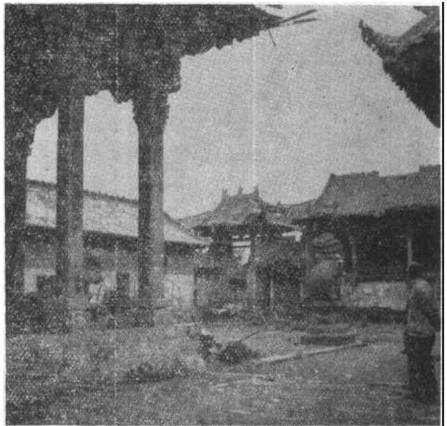
图102 河南会馆内院
