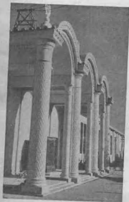
蘇聯展覽館建築外景一角 (食品館入口處)
