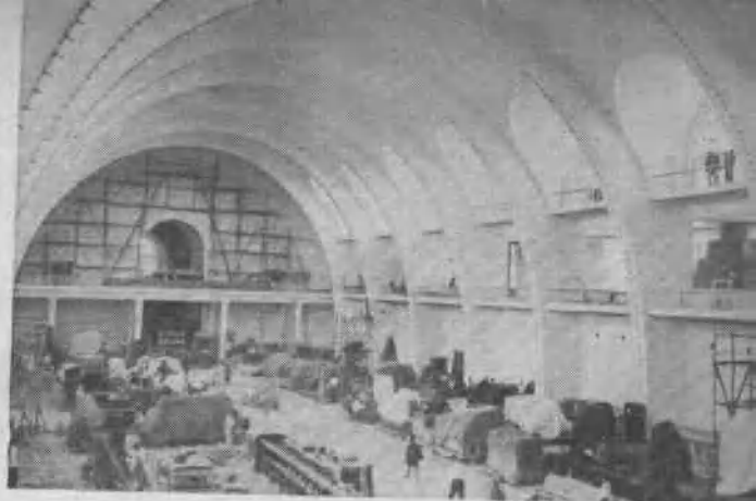
正在安裝機器的工業館
