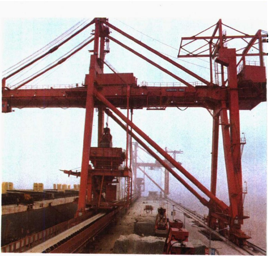
宁波北仑港十万吨级泊位
