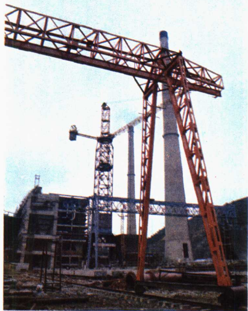
台州发电厂二期 工程在建设中
