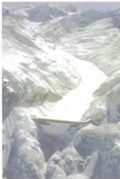
1-02 水电站和输送管道：大迪克桑斯坝（Grand Dixence），1961。
