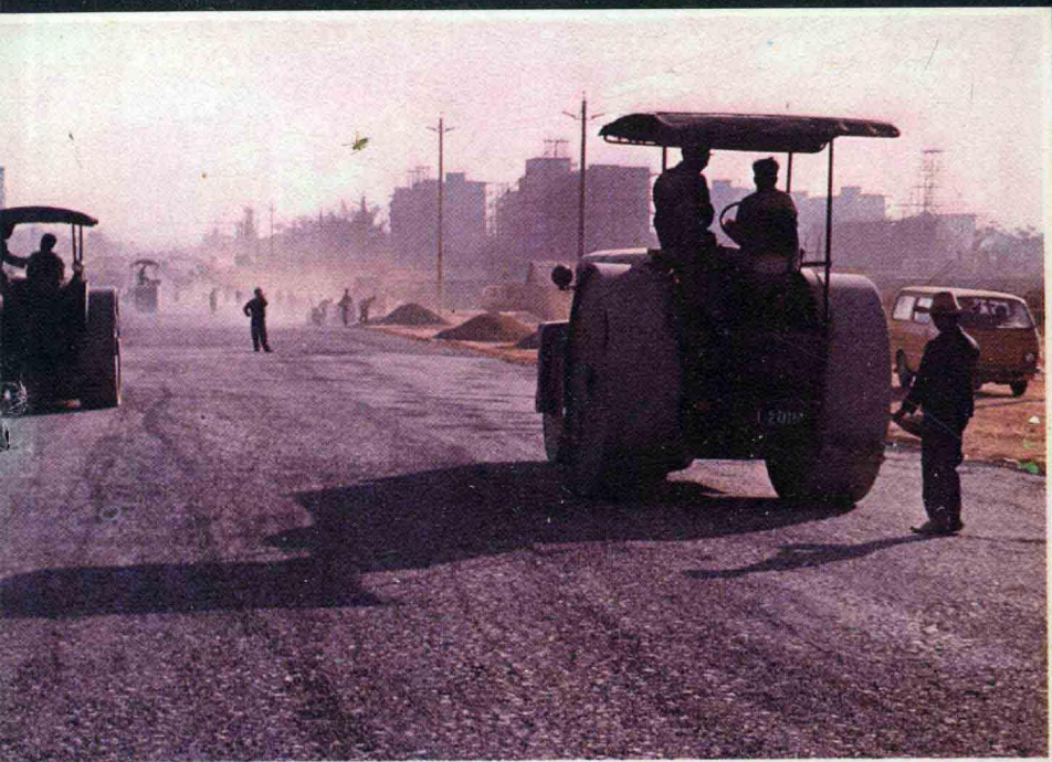
▲建设中的深圳市主干道深南大道
