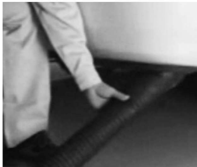
图1-1-12 安装排气管接管
