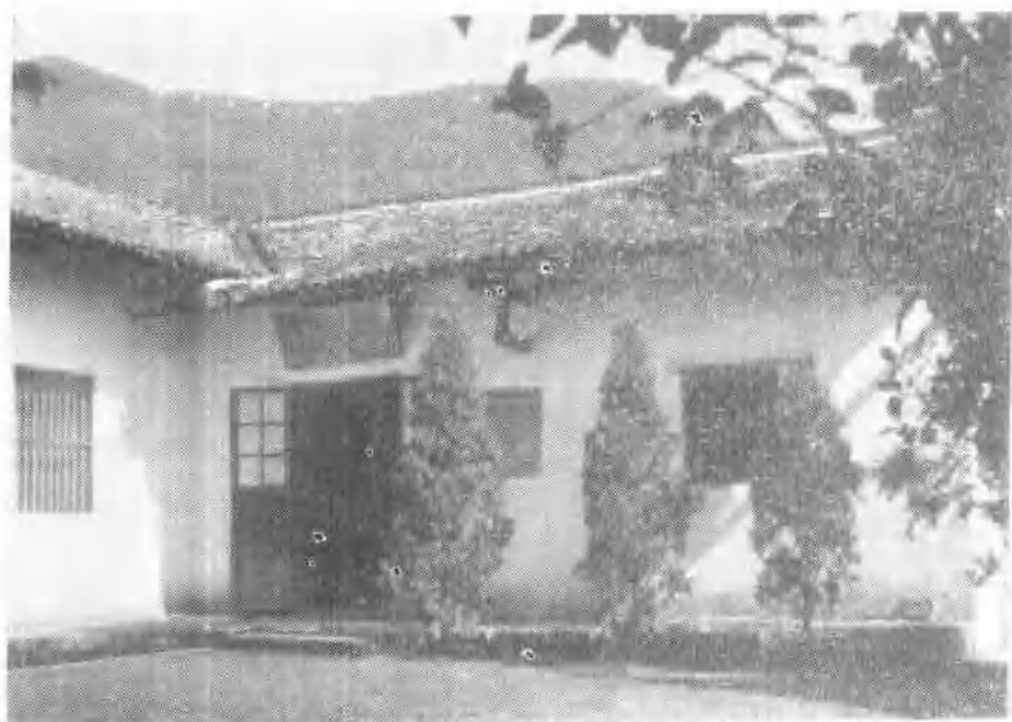
安源路矿工人俱乐部旧址
