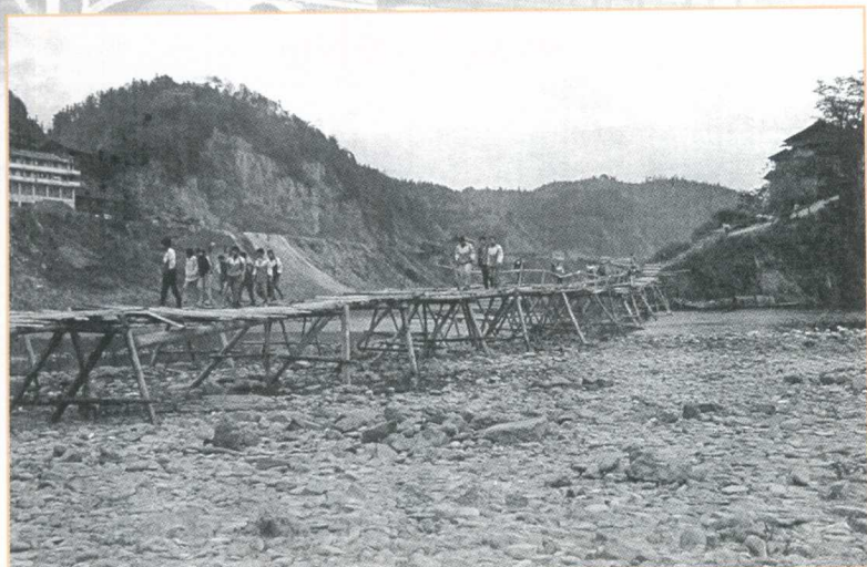
秋冬枯水期架浮桥替代渡船
