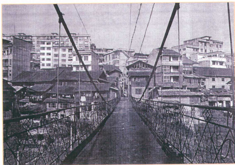
赤溪坪铁索桥一隅
