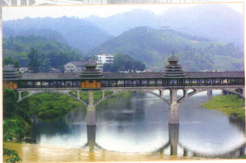
赤溪坪风雨桥
