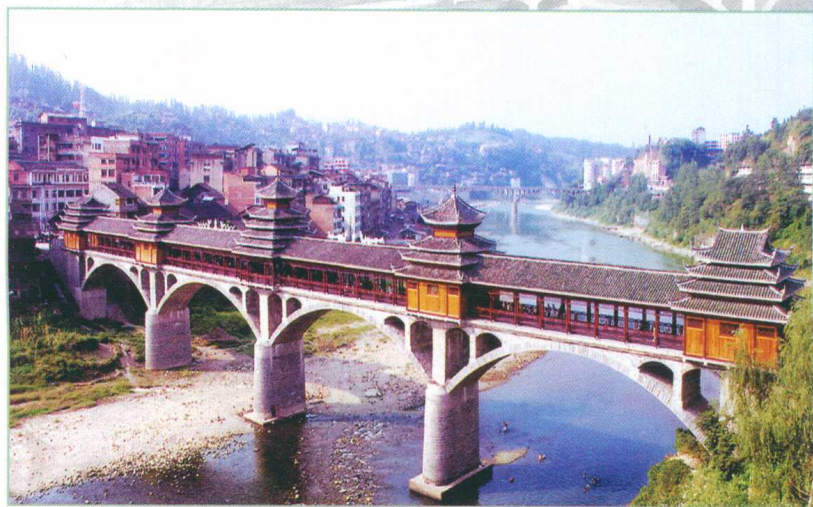
赤溪坪风雨桥全景
