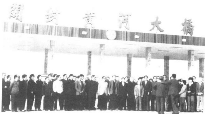
▲ 曾为建造黄河大桥奔走呼吁的政协委员来到工地视察。
