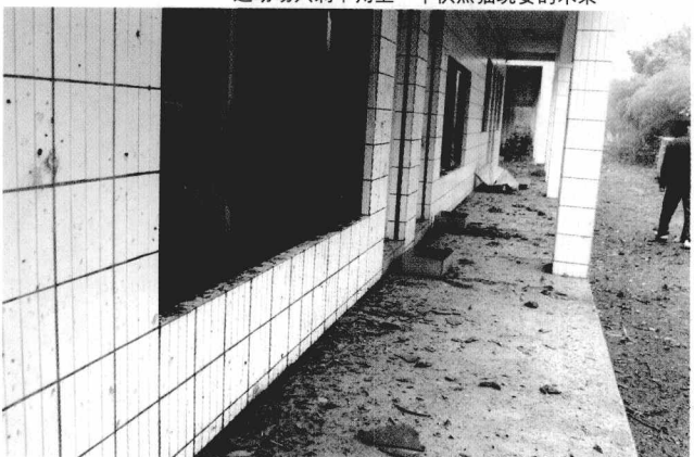
繁殖区的墙壁，玻璃被飞石打得千疮百孔
