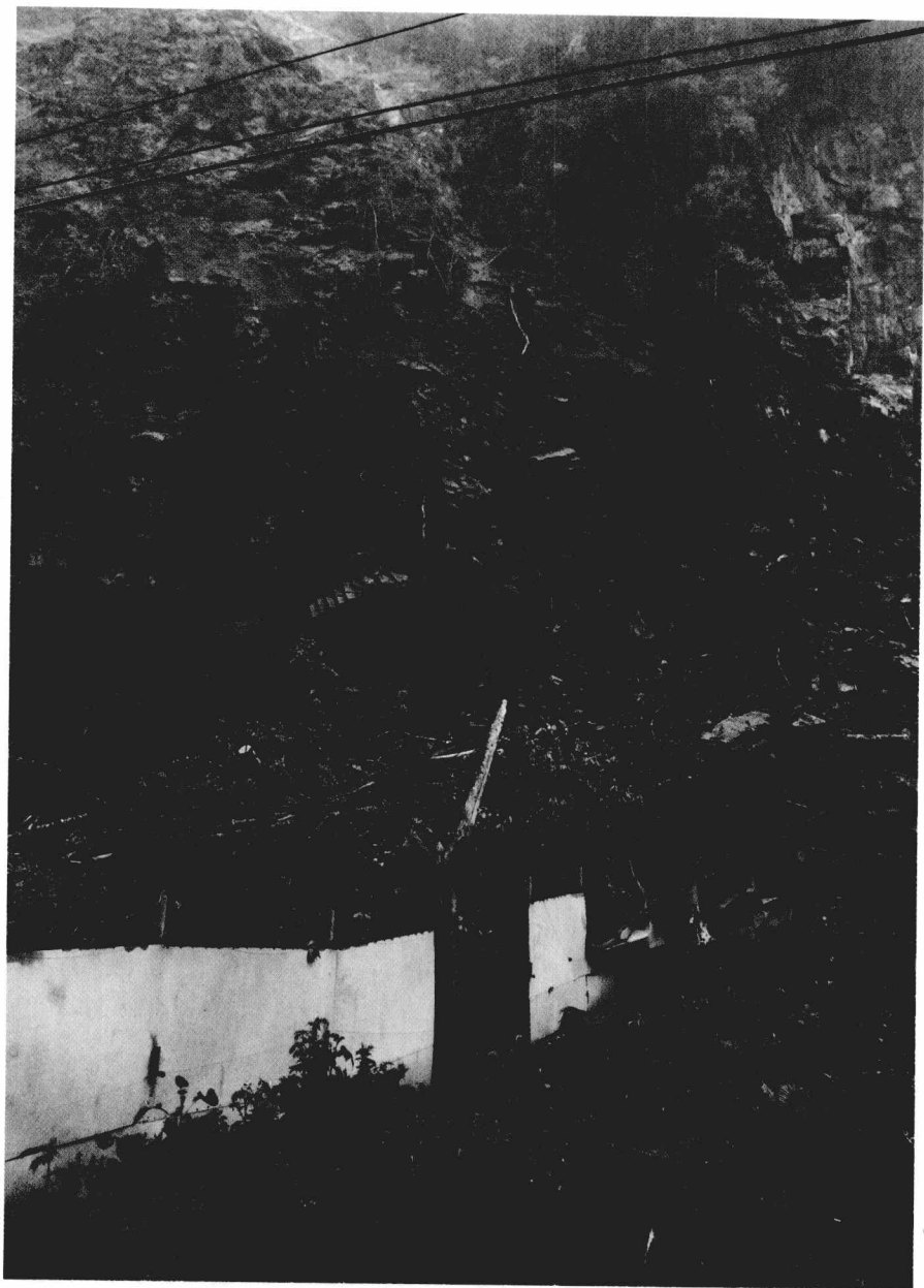
研究中心大熊猫苑内遭受了严重的破坏，位于饲养场最远端的深圳园的一半已经被塌方掩埋
