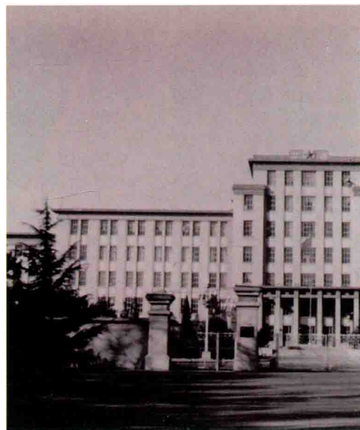
北京矿业学院主楼 (1964)
