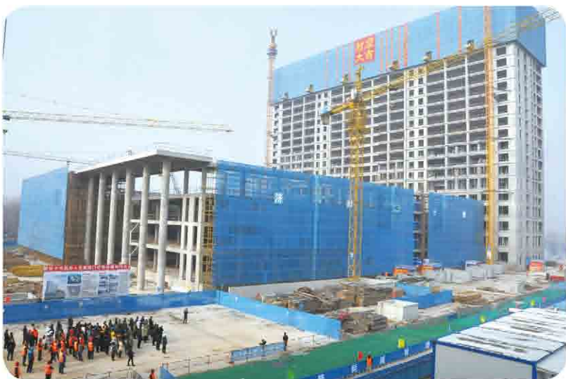
12月30日，东昌府人民医院新院区顺利封顶。
