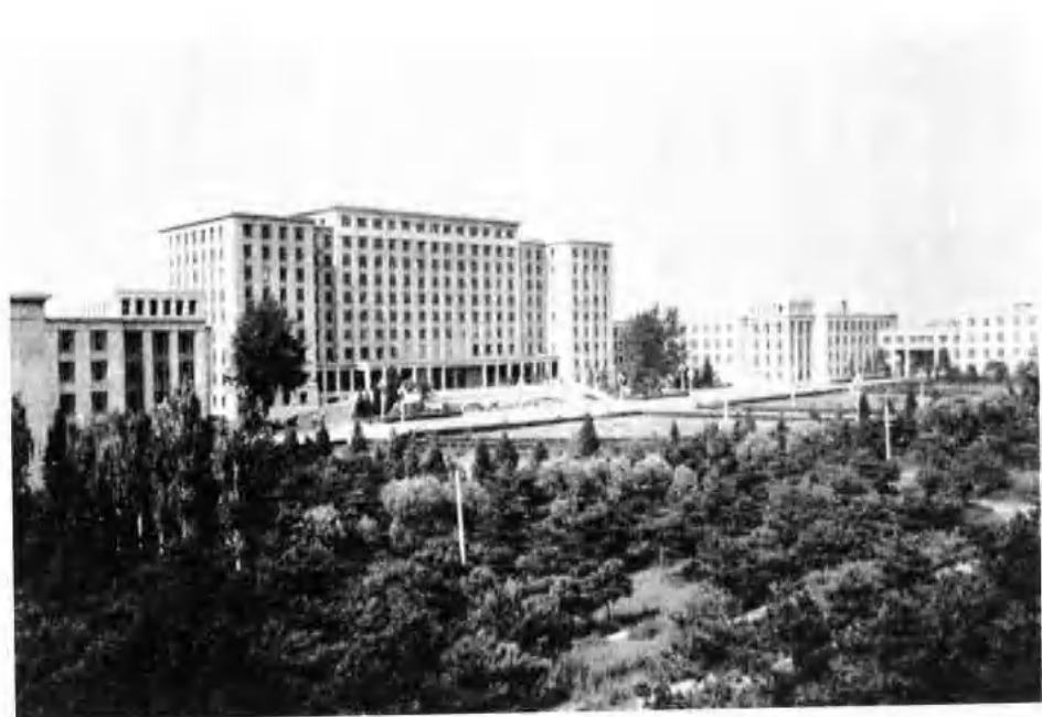
14. 清华大学 50 年代新建的大楼。
