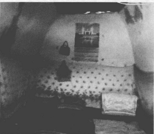
海原现存易倒塌的拱窑
