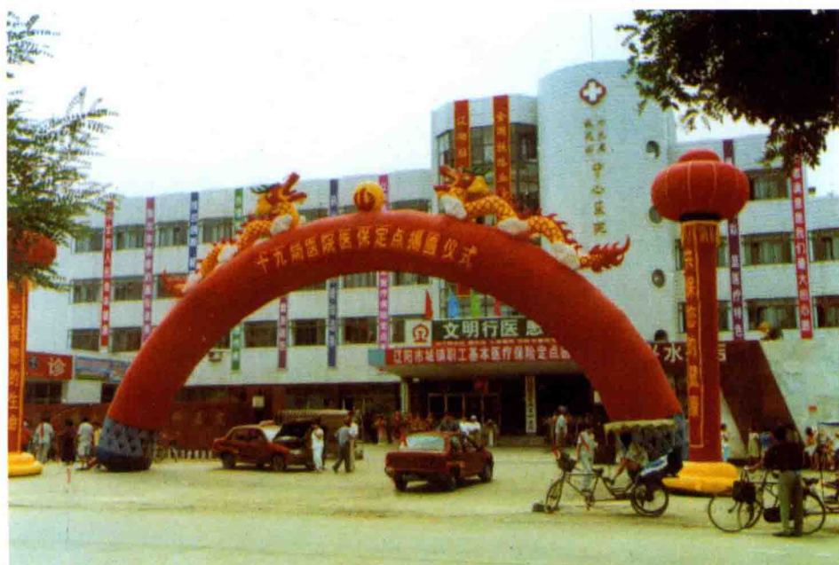
十九局医院门诊大楼
