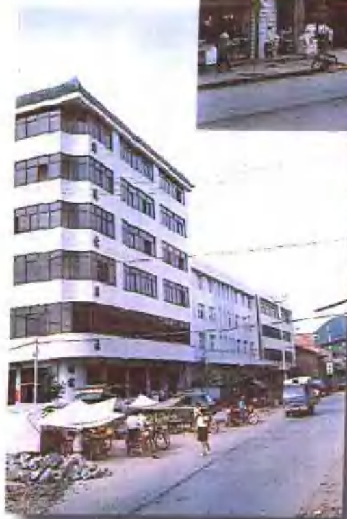
鸡笼信用社办公楼
