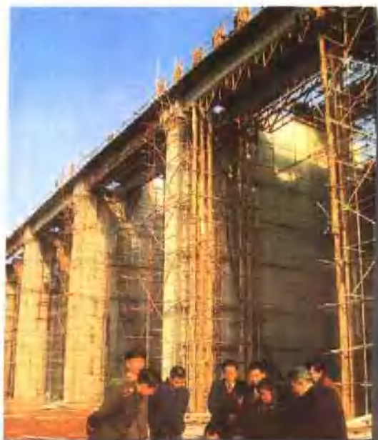
正在建设中的湖南省「八五」重点工程近尾洲水电站
