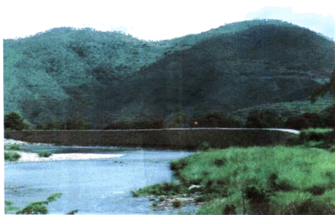
重修的莒江防洪堤（施明达摄）
