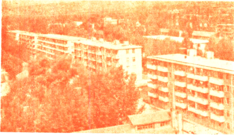
渭工路上的新住宅
