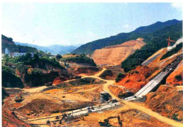
桃源水库建设工地
