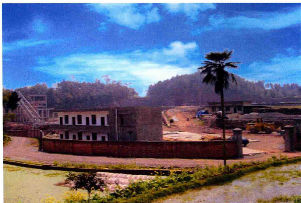
2004 年 3 月落户围龙镇三关村的重庆市雄龙汽车配件有限公司。征地 85 亩，陆续投入 2300 万，从事精煤洗选和汽摩配件生产，年产值超亿元。左为正在建设的精煤洗选线，右后为 2006 年 4 月 2 日开工新建的汽摩配件生产车间。
