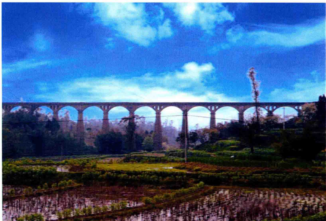
位于围龙镇立石村二社的董家沟渡桥，始建于七十年代。是围龙、河中、茨芭等村农作物灌溉引水渠道。
