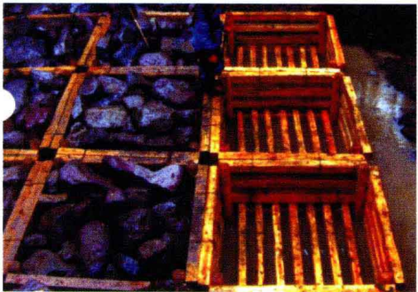
第2阶段的木工沉桩
