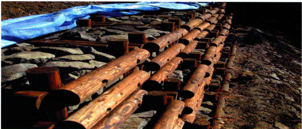
第2阶段的与自然共生施工法的一例（多目的木制架）
