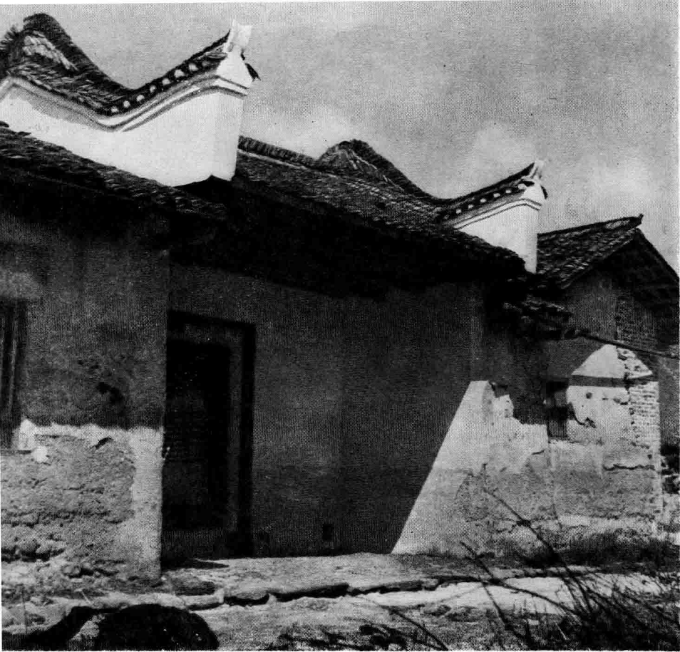
毛泽东同志旧居—— 桥头江家。
