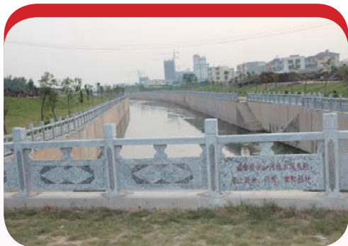
2014 年，北海市大力推进城市建设。图为建设完成的市区内涝整治（二期）工程——铁路北侧排水明渠
