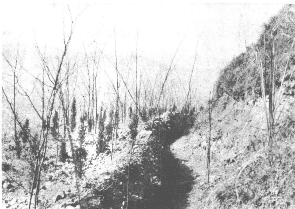
洋槐柏木混交林与排水沟结合治理仙隐山水土流失
